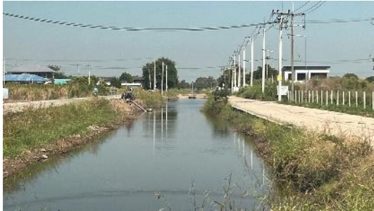
กม.16+211 คลองส่งน้ำ 5 ซ้าย
