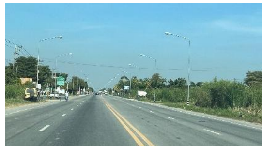
บริเวณจุดสิ้นสุดโครงการ กม.19+033.500
